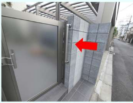
コンクリ塀側面の施行例
