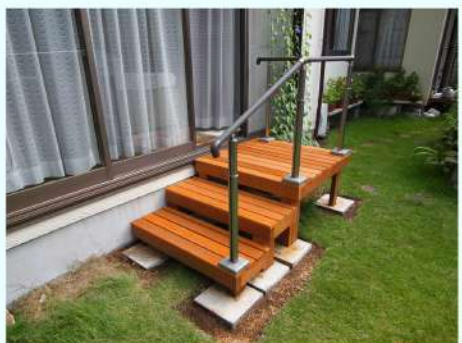
上：手すりとスロープの施工例 下：掃出し窓の高さに合わせた 踏み台を新設した施行例
