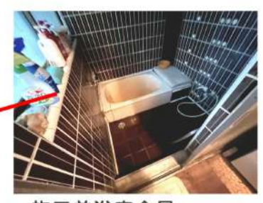
施工前浴室全景
