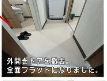
外開きドアを撤去。全面フラットになりました。
