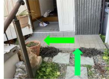
階段を上がっても、次は90度曲がらなくてはならない。
