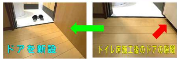
床下げした為ドアの下に隙間が。長さを合わせたドアを新設。
