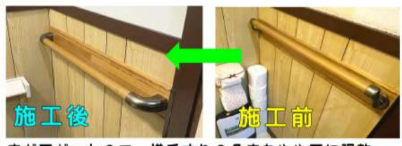
床下がったので、横手すりの角度をやや下に調整。
