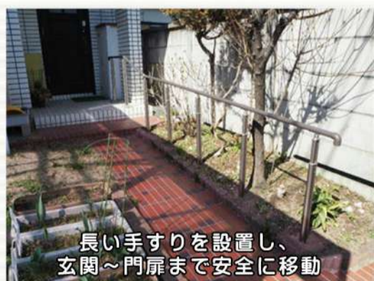
手すり取付に加え、スロープにも滑り止めを処理した施工例
