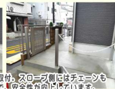
スロープに穴を空けて取り出し口を作り、ポストの位置を変えないよう施工。さらに車輪が落ちないようにフタが出来るようにしました。
