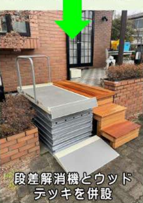
段差解消機と歩行用階段を併設
