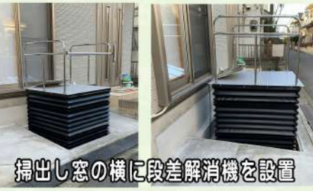
段差解消機と歩行用階段を併設
