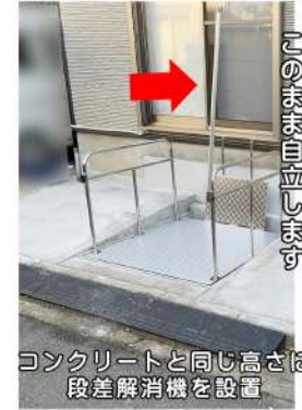
ピット施工時写真②
