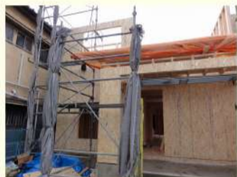
※上記工事写真は、2021年1月時点のものです
