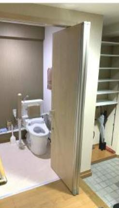
まずはトイレ入口の段差解消として、トイレの床面を下げる方法を考えました。ご自宅がマンションの為、トイレ床下の下水管を下げる事が不可能であることから、床上排水に切り替える提案をさせていただきました。これにより、現在の配管を下げることが可能となり、廊下から段差無しでトイレに入れるようになりました。
