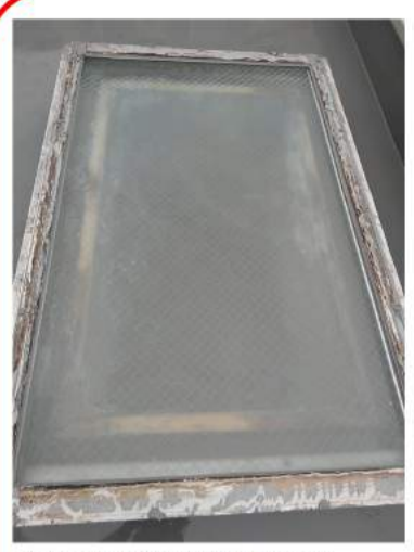
外壁のひび割れ補修はもちろん、天窓も新しいものに交換しました。
