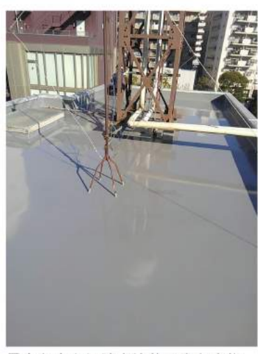
屋上を中心に防水塗装工を実施。見違えるほど美しい仕上がりになりました。
